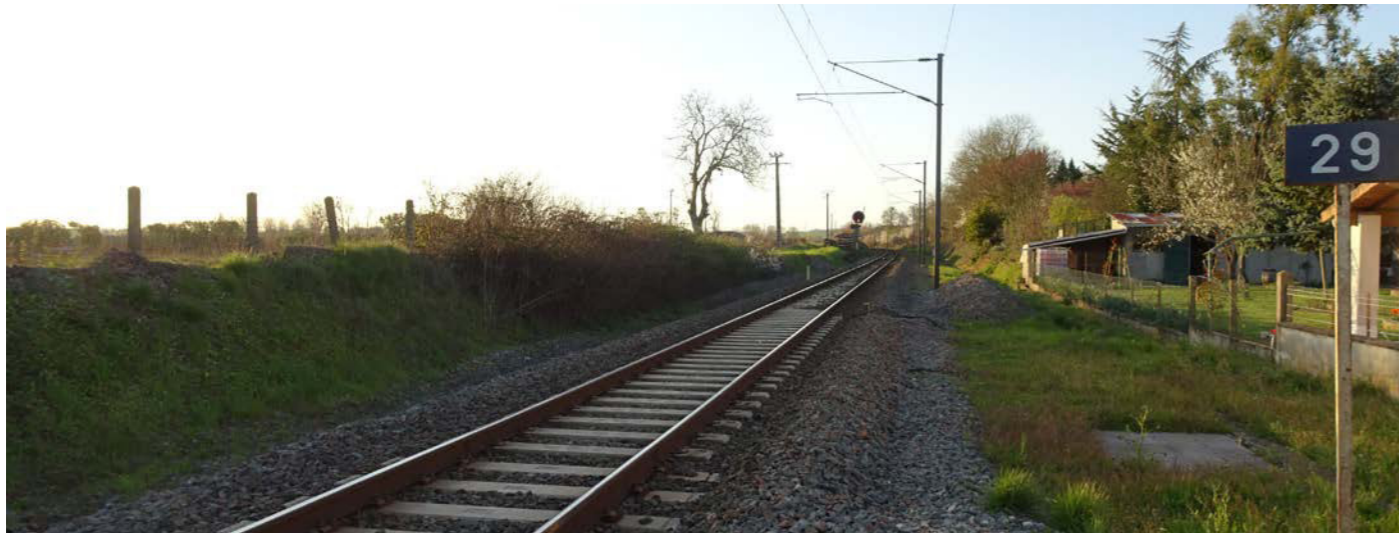
PHOTO 54 : LA VOIE FERRÉE LONGE LE PIED DU VERSANT EST DE LA VALLÉE DE LA SÈVRE NIORTAISE - LES PERCEPTIONS VERS LA ZIP SONT AINSI RÉGULIÈREMENT FERMÉES PAR LE RELIEF
