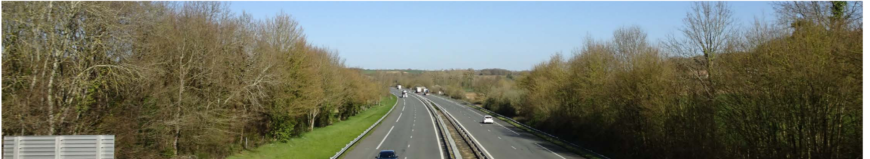
PHOTO 56 : VUE OUVERTE VERS LA ZIP DEPUIS L'AUTOROUTE A10
